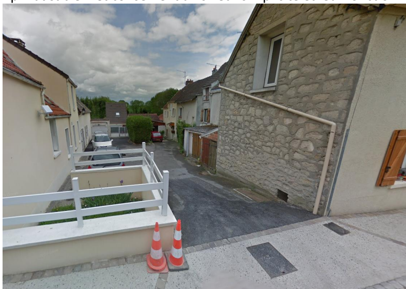
Figure 84 Cour commune, rue du Bois, Moussy-le-Vieux, Maps
