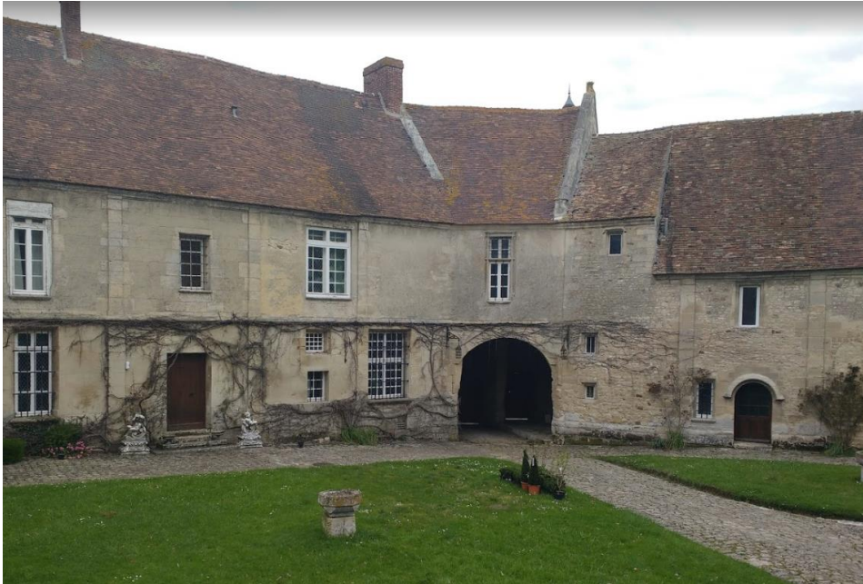
Figure 120 Corps de ferme du château
