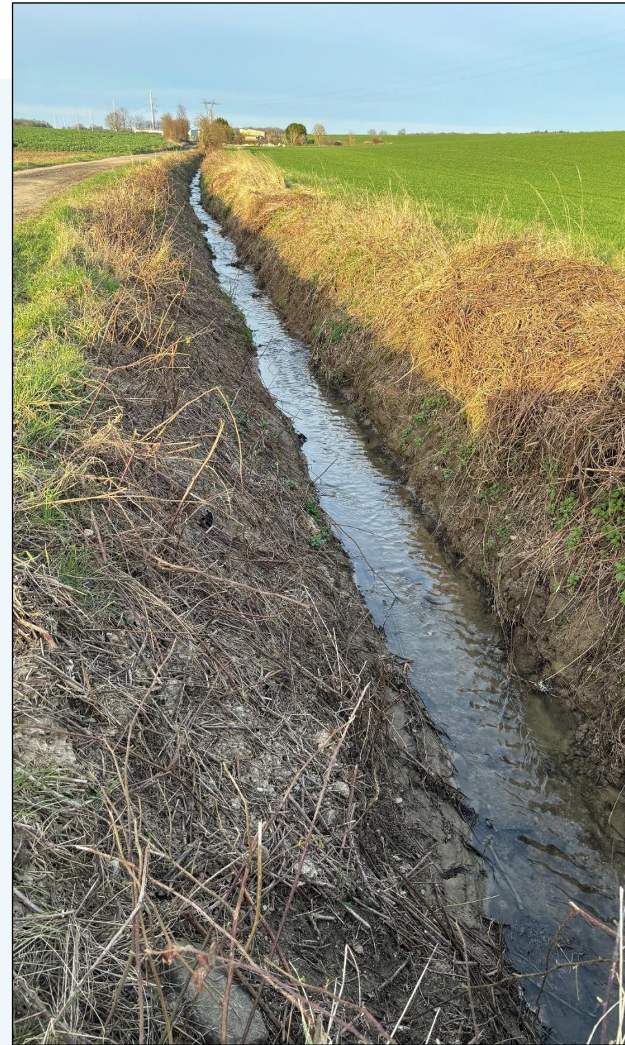
Photo prise après les travaux
