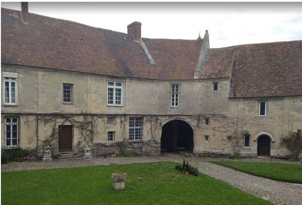
Figure 103 Corps de ferme du château
