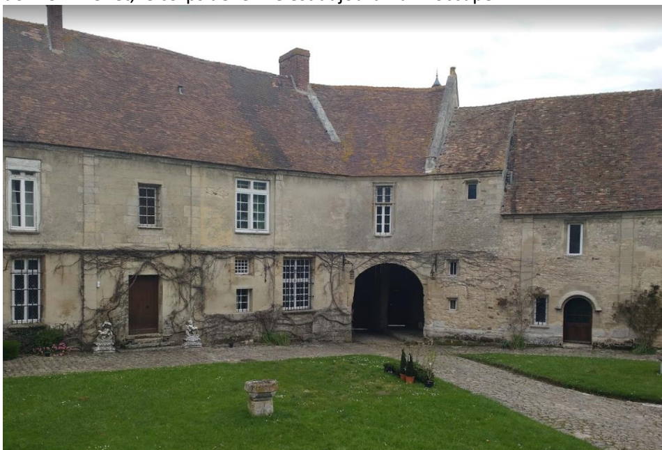
Figure 122 Corps de ferme du château
