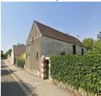
Figure 84 Construction ancienne, rue de l'Hermitage, Maps, 2019
