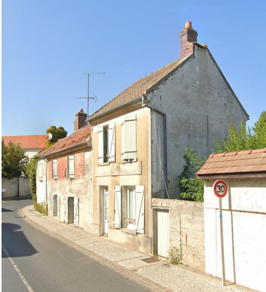
Figure 83 Maison ancienne ayant subi des modifications ou des "maltraitances" architecturales, Moussy-le-Vieux, Maps
