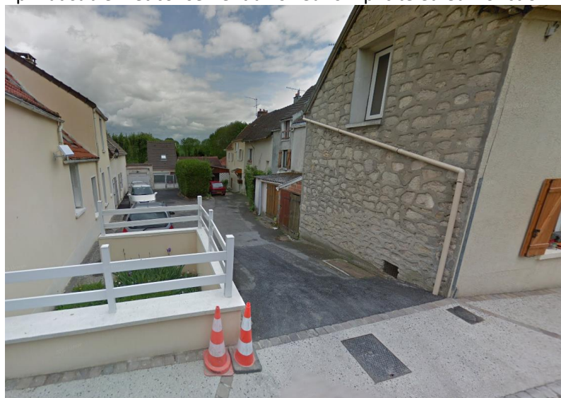
Figure 86 Cour commune, rue du Bois, Moussy-le-Vieux, Maps
